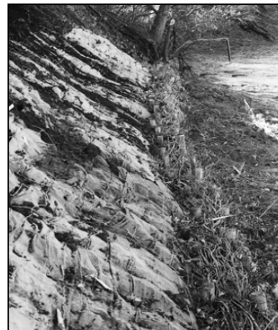
Généralement, une seule rangée de fascines est appliquée dans le bas d'un talus
