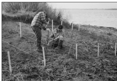
Des trous sont faits dans le sol à l'aide d'une tige métallique pour planter les boutures.
